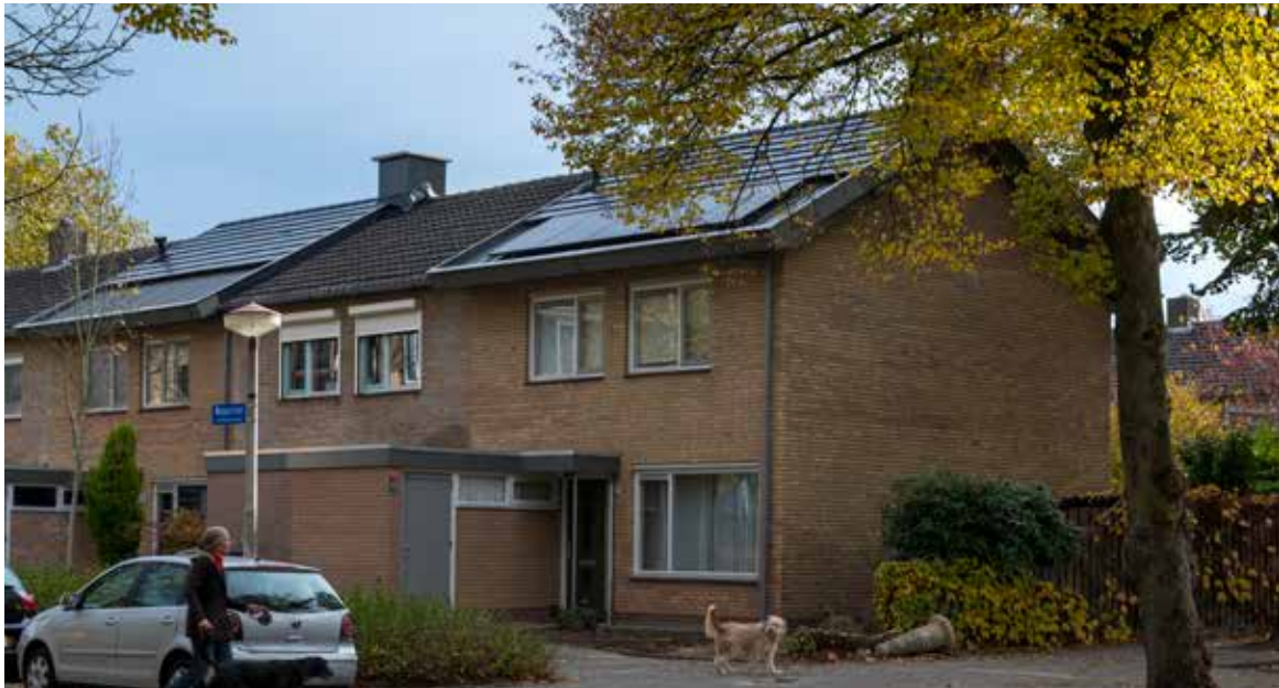
Woonbedrijf plaatste zonnepanelen op huurwoningen in Vaartbroek
